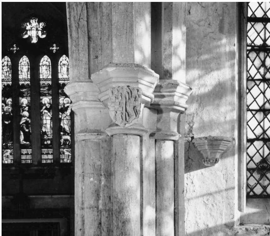
Chambre chantry detail
